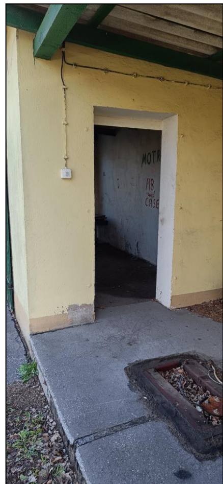
Foto 3: östlicher Eingang, Blickrichtung Nordwest
