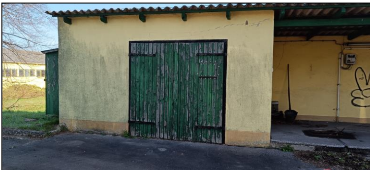
Foto 2: Öllager Außenansicht, Blickrichtung Nord
